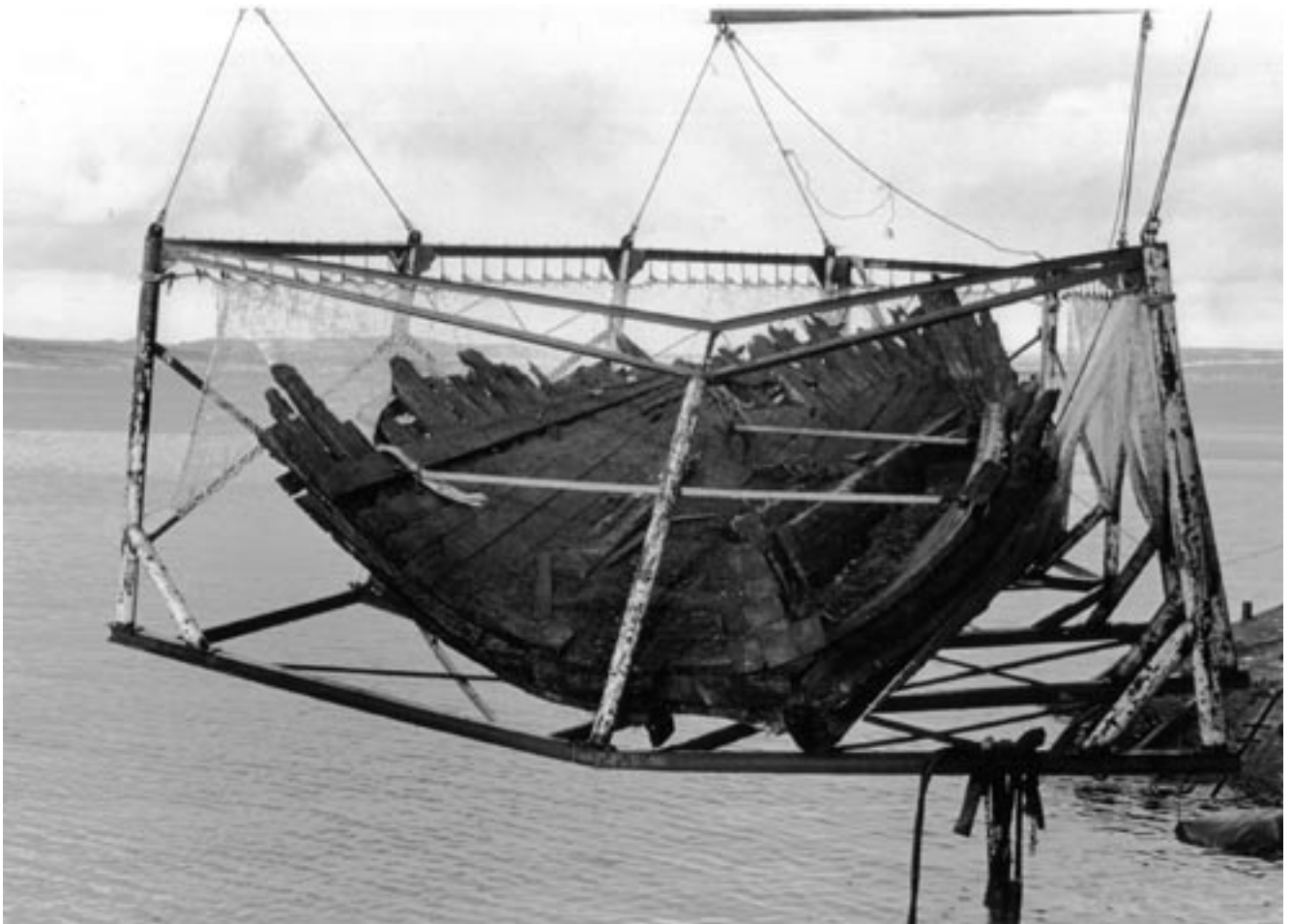
Abb. 1: Der Bugabschnitt der Snow Squall wird in Port Stanley (Falkland-Inseln) an Deck des Containerschiffes Assifi gehoben. Man beachte die Durchbiegung des Heberahmens, die einige Schrecksekunden hervorrief. Innerhalb des Schiffskörpers sind der Kielschwein-Aufbau und die Fockmastspur sichtbar.
